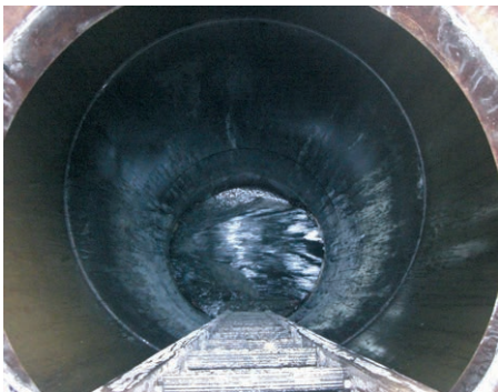
通過マンホール
